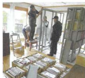
新建物で書架組立て
